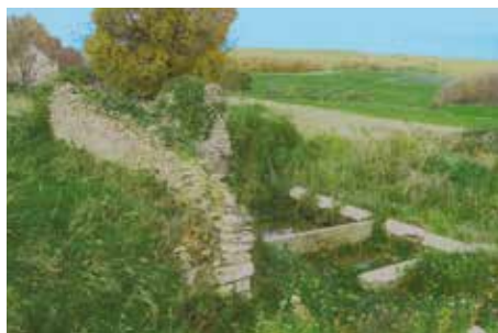
Murs et bassins du lavoir de St Caprais (domaine privé), alimentée par la source canalisée et couvert à l'origine par un toit de tuiles à 3 pans (identique au lavoir de Butel)
