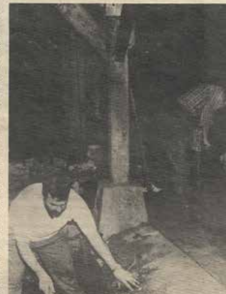
Depuis samedi dernier, les travaux de restauration ont commencé au lavoir des Maurois.
