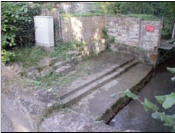
Aujourd'hui les restes du lavoir associent l'ancien et le moderne!
